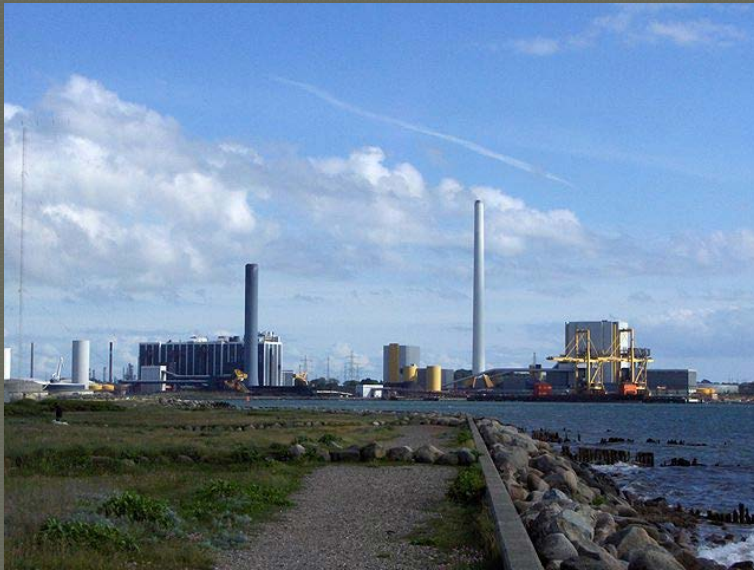
Centrale thermique (charbon), Kalundborg
